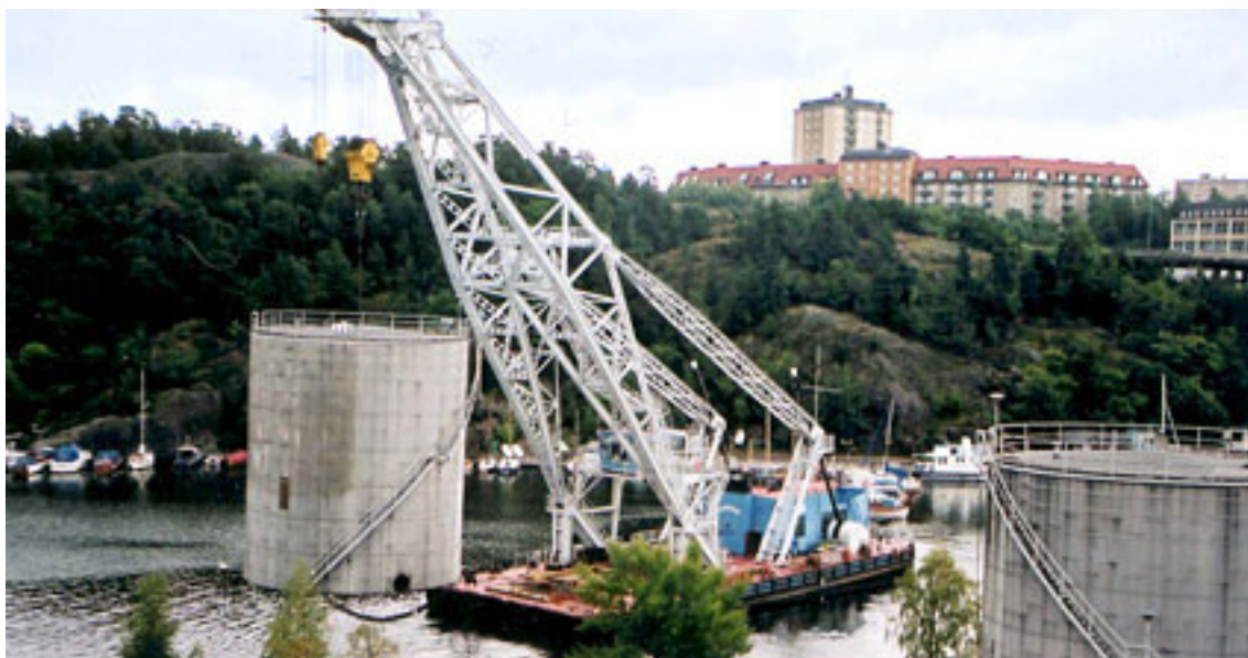
En väldig sjökran användes för att på pråm frakta cisterner till annat depåområde.
